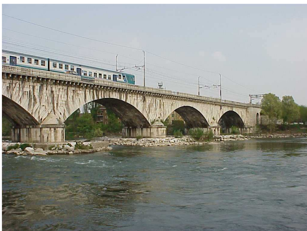
Attraversamento fiume Adige
